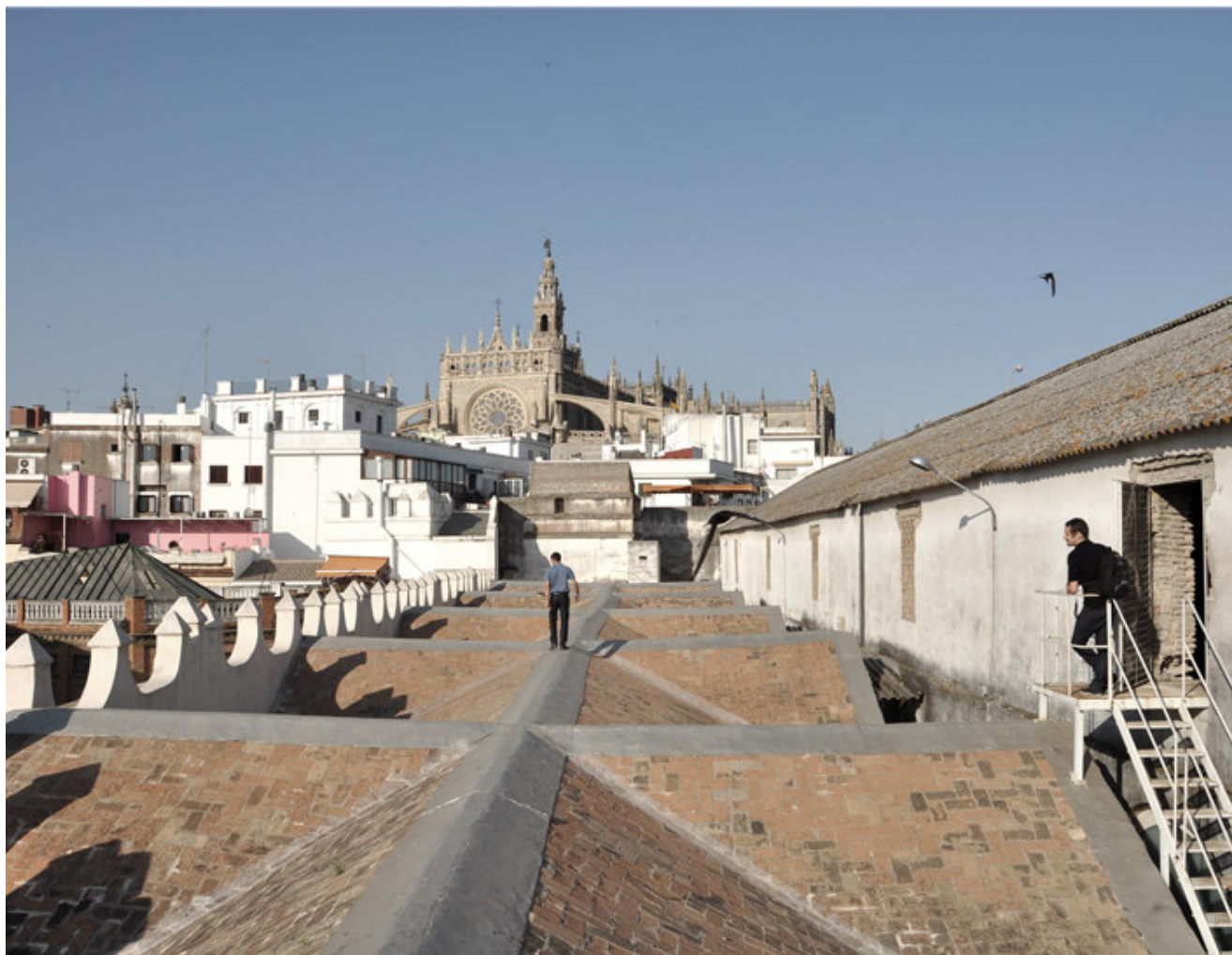
TERRAZA SUPERIOR_ESTADO ACTUAL
